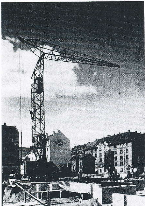
Oben: Der erste Hilgers-Baudrehkran (BDK 75), erbaut 1950. - Unten: BDK 300 (Baujahr 1952) auf einer Baustelle in Nürnberg.
