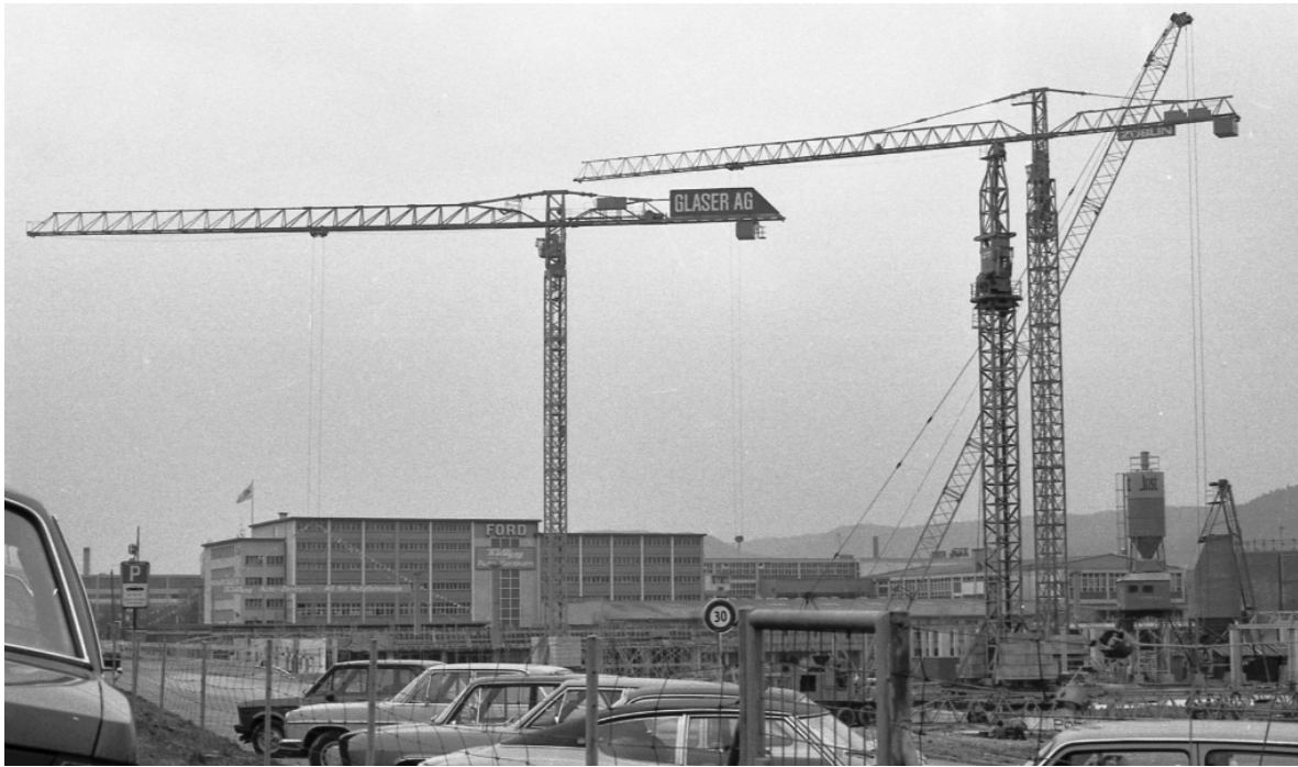
Richier Weitz GT 1362 rechts, links BPR GT 329, Nachfolgemodell des GT 1297. Baustelle PTT Mülligen Schlieren 1978. Im Vordergrund wird ein Potain 743 E montiert.
