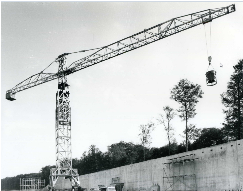
Weitz G 280 HV. Baustelle Galerie Schweizerhalle. Unternehmer Züblin.
