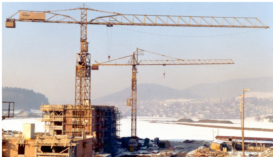
Richier Weitz GT 1220 auf einer Baustelle in Zürich Seebach 1973 oben, X 1265 BL CH 2 in Ostermundigen unten.
