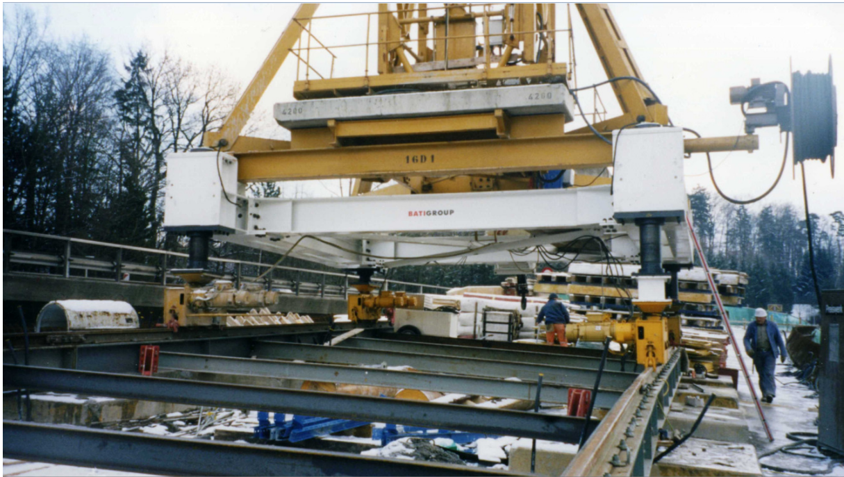
GT 1372 mit höhenverstellbarem Unterwagen für den Brückenbau in Zürich Brunau.
