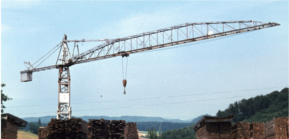
Weitz G 20. Ausladung 25 m , Tragkraft 1000 – 2000 kg.
