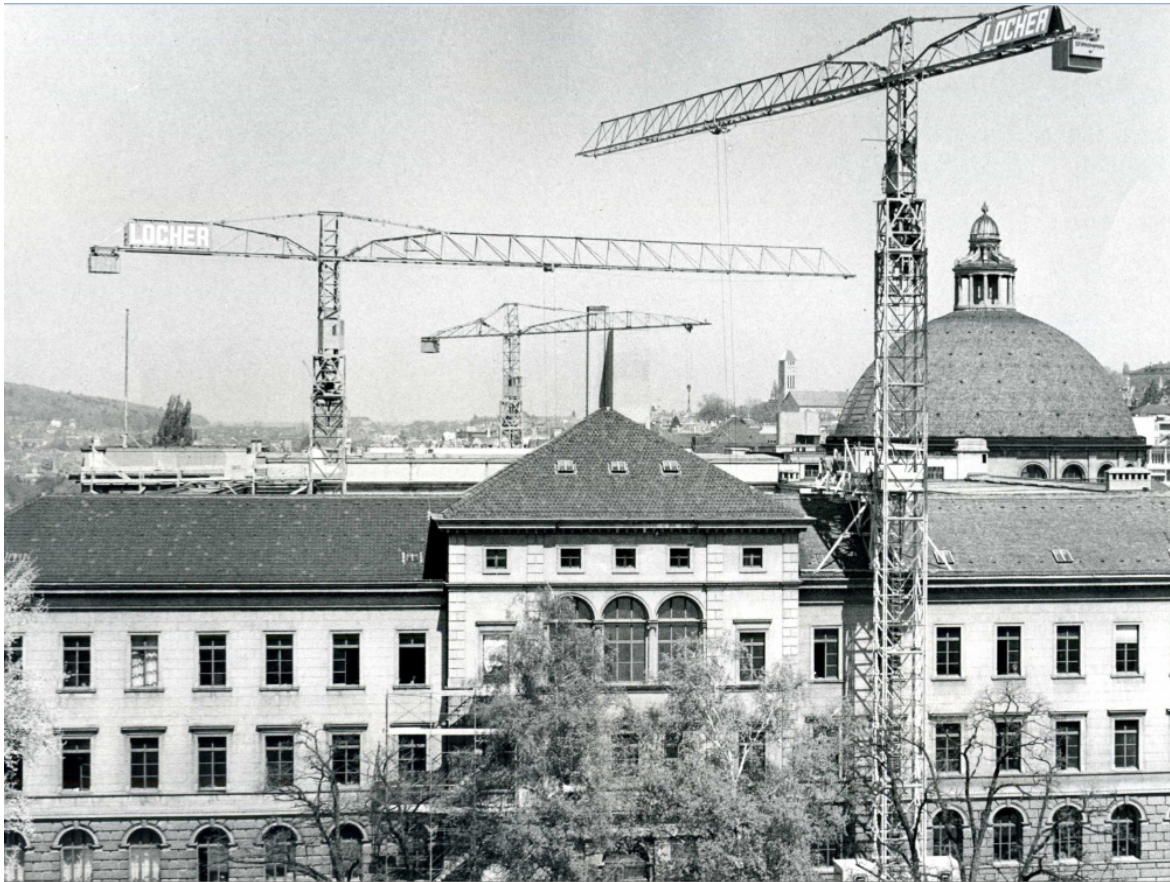
Richier Weitz Krane Serie 12 und G 45 HV im Hintergrund. Baustelle ETH Zürich. Unten X 1220 und X 1265 auf einer Baustelle der Firma Züblin.
