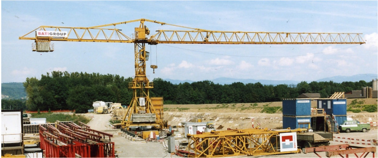
GT 1372 Baustelle Rheinfeldern.
