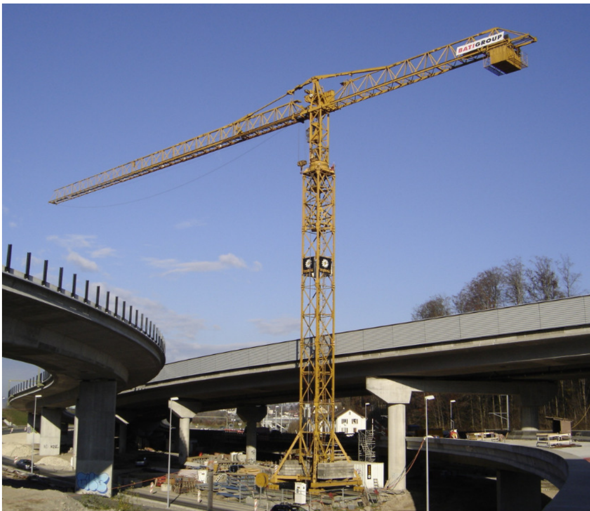
Richier Weitz GT 1372 B. Baustelle Zürich Brunau 2006.
