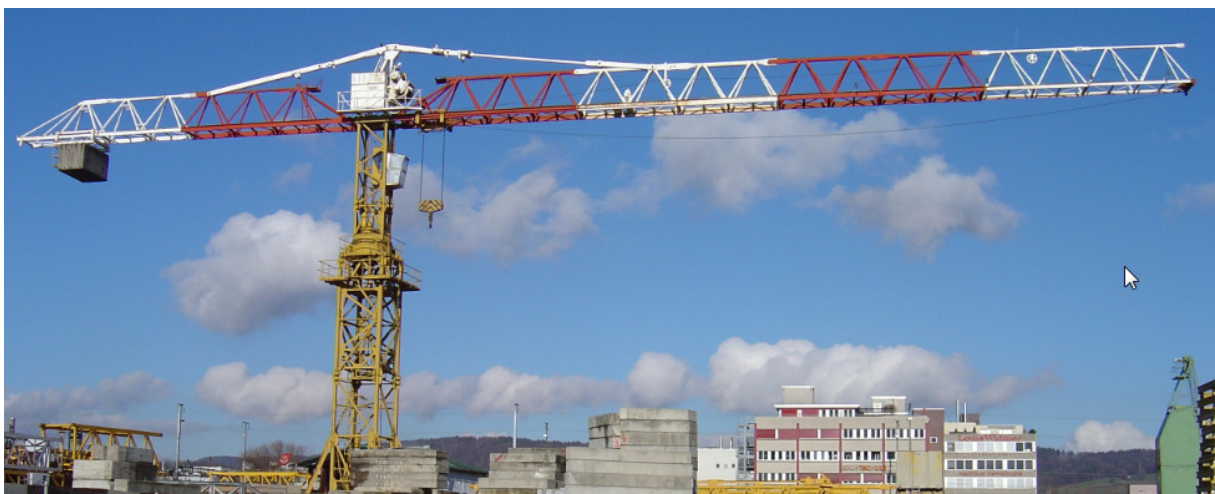
GT 1372 mit höhenverstellbarem Unterwagen für den Brückenbau in Zürich Brunau.
