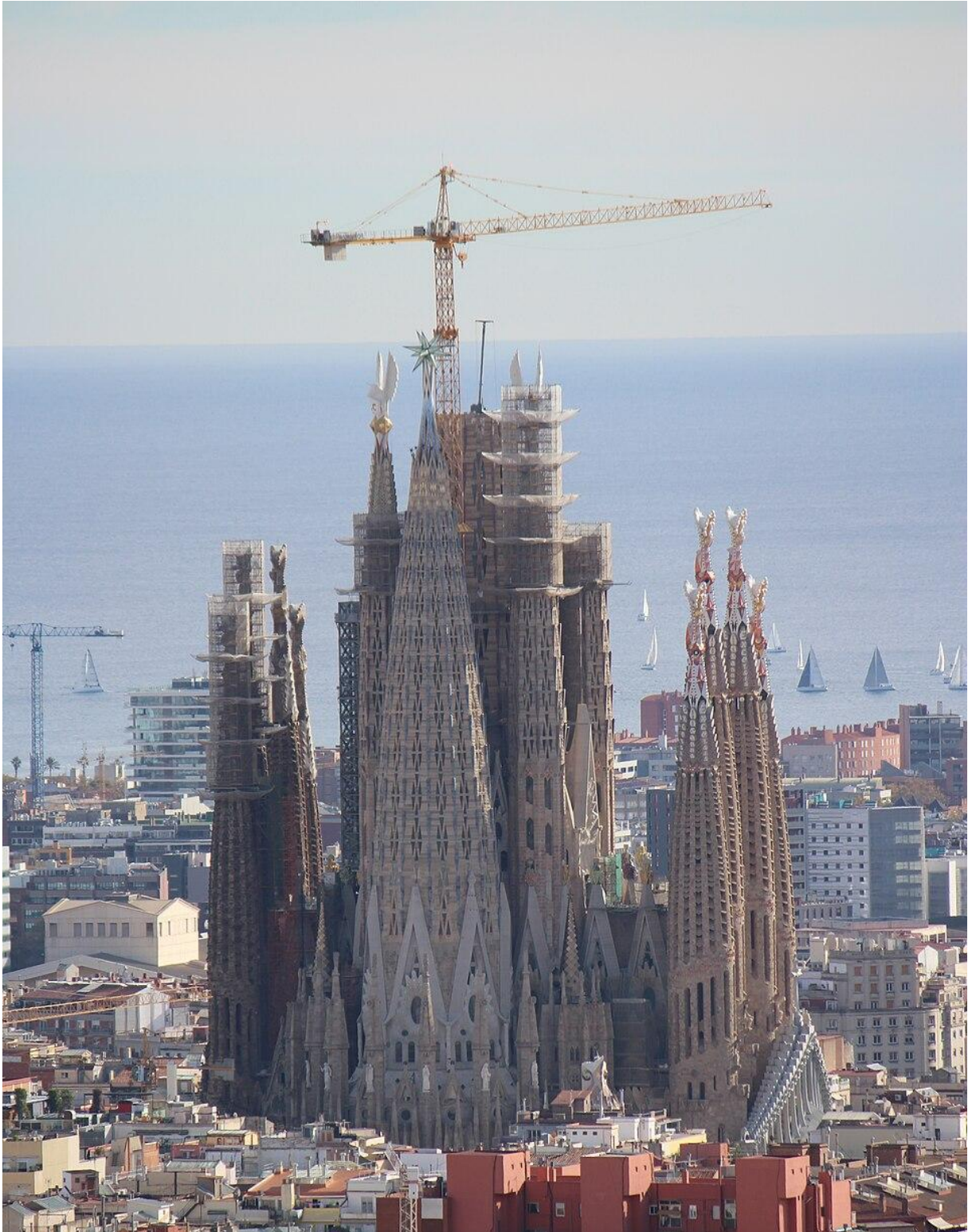
Stand der Bauarbeiten im Februar 2023. Foto Wikipedia.
