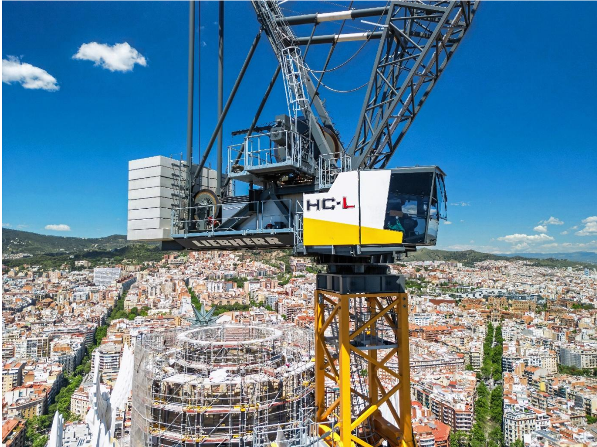
Liebherr-Verstellauslegerkrane im Einsatz für die Endphase des Sagrada Familia-Bauprojekts - Liebherr
