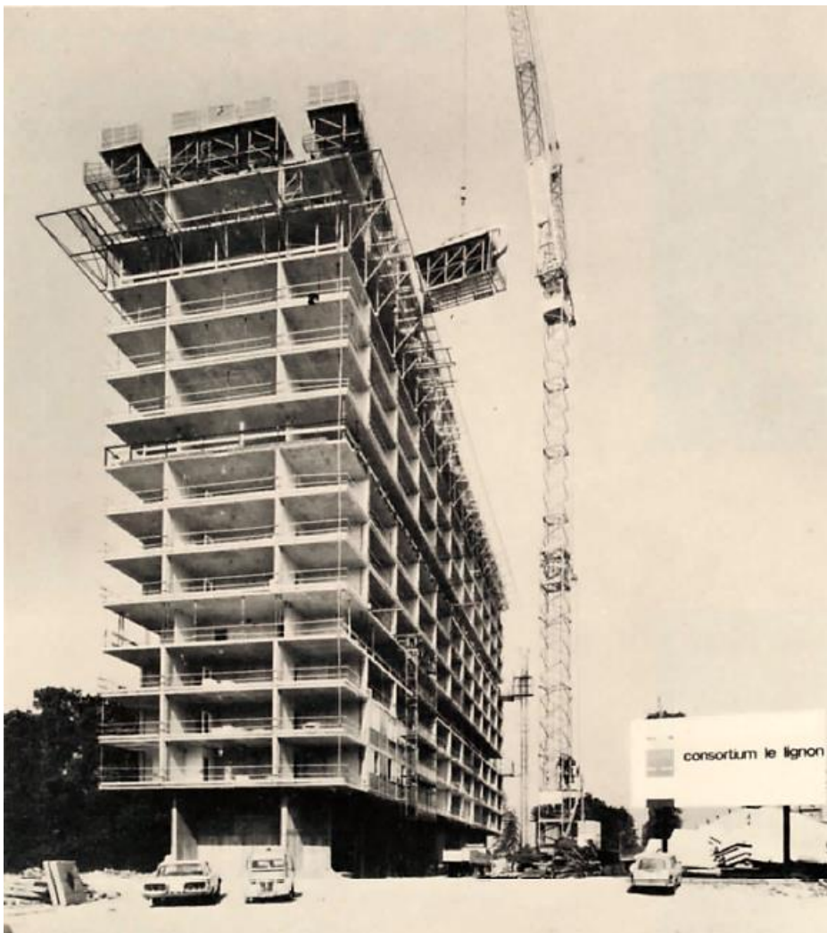
Liebherr Form 128/170 beim Versetzen der kompletten Deckenschaltische
