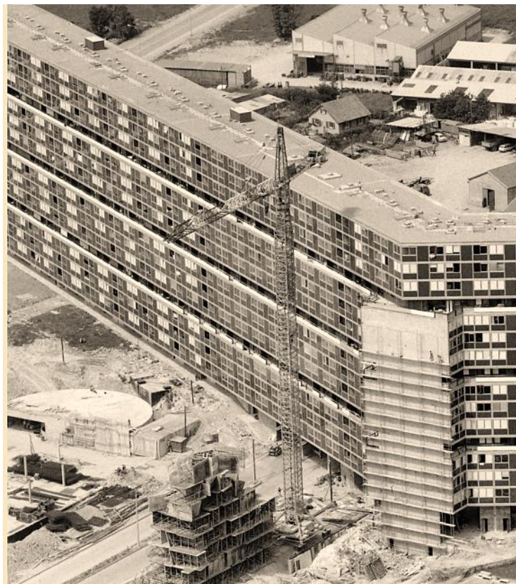
Bauzustand in Le Lignon (CH) im Juni 1967
