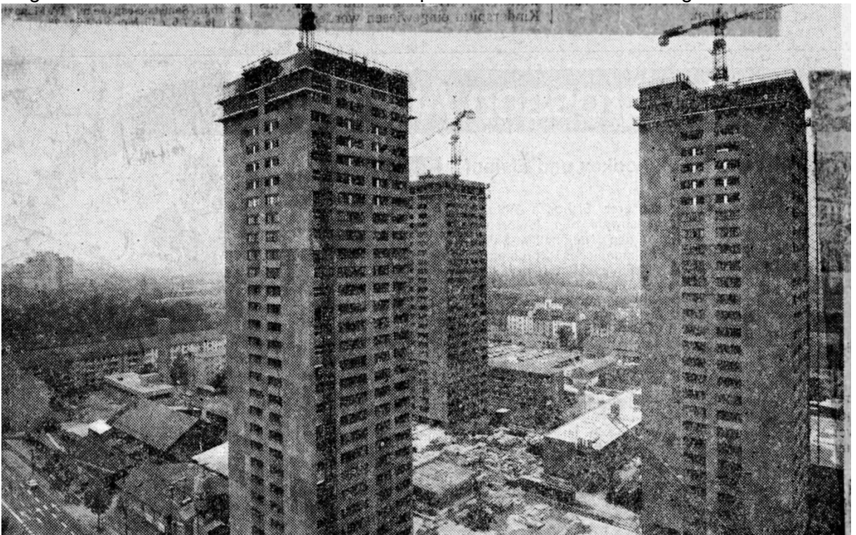
Übersicht über die Baustelle im September 1975. Der Rohbau des ersten Hochhauses ist bereits beendet, die Anderen stehen kurz vor der Vollendung. Der eingefärbte Beton der Fassaden war sehr anspruchsvoll in der Verarbeitung.
