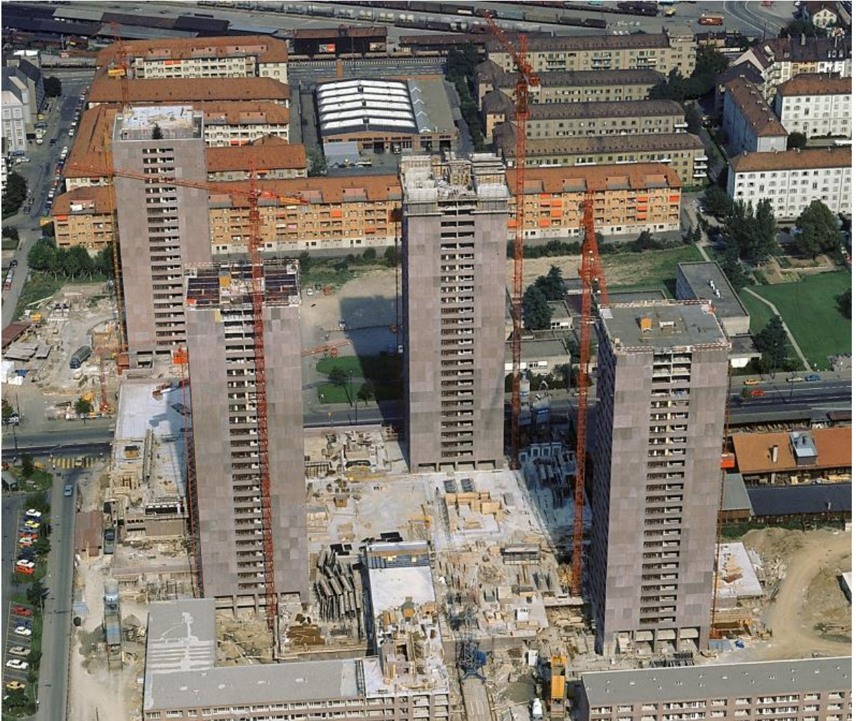
Übersicht über die Baustelle im September 1975. Der Rohbau des ersten Hochhauses ist bereits beendet, die Anderen stehen kurz vor der Vollendung. Der eingefärbte Beton der Fassaden war sehr anspruchsvoll in der Verarbeitung.
