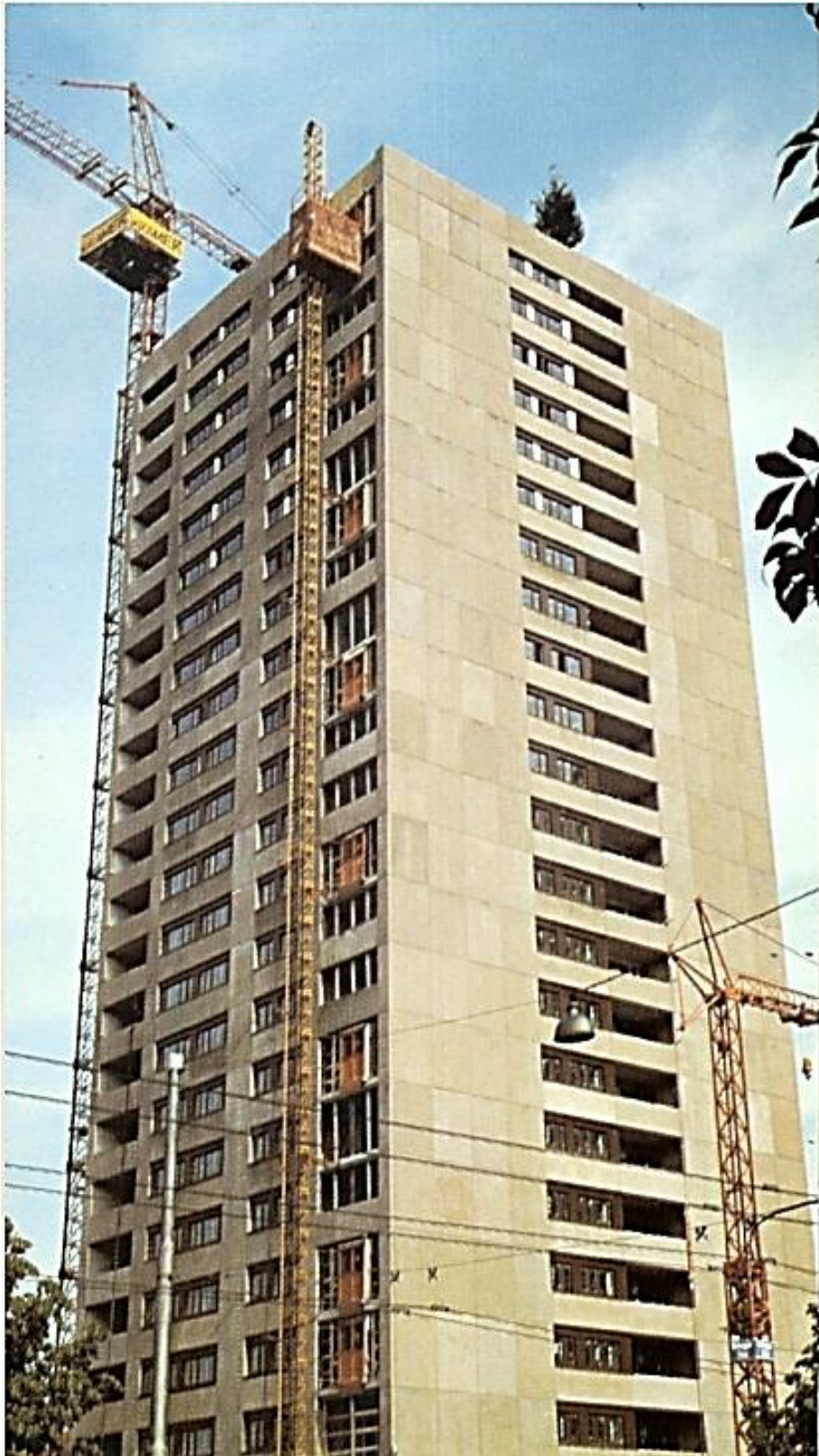
Peiner KL 80 beim Bau des 72 m hohen Hochhauses mit Habegger F 20. Für den Personentransport des Baustellenpersonals wurde ein Bauaufzug eingesetzt.
