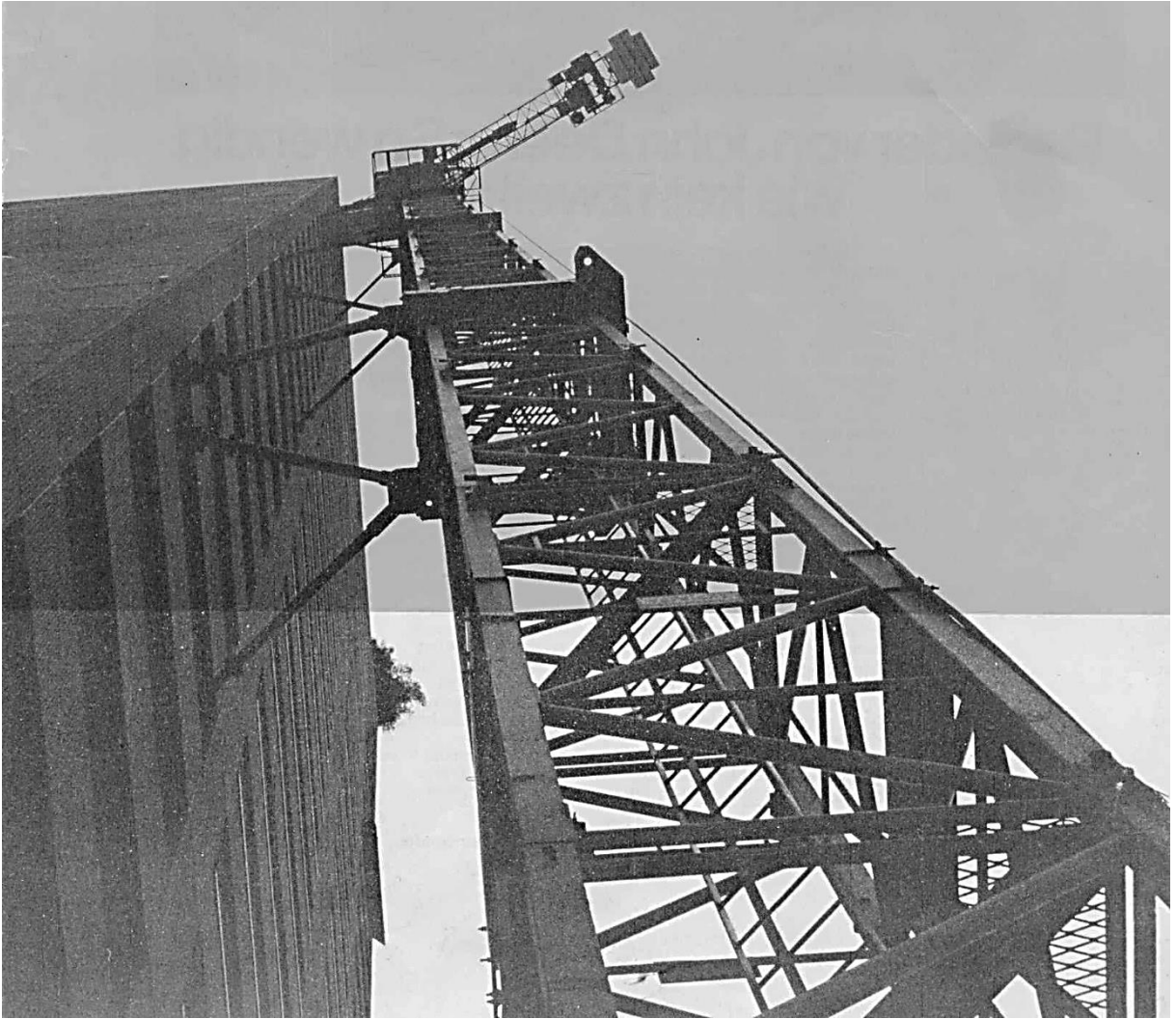
Wolff WK 80 S mit Verankerungsrahmen und mehrfacher Gebäudeabspannung an einem der Hardau Türme. Geklettert wurde mit dem Wolff Aussenkletterwerk angetrieben durch Rollenketten.
