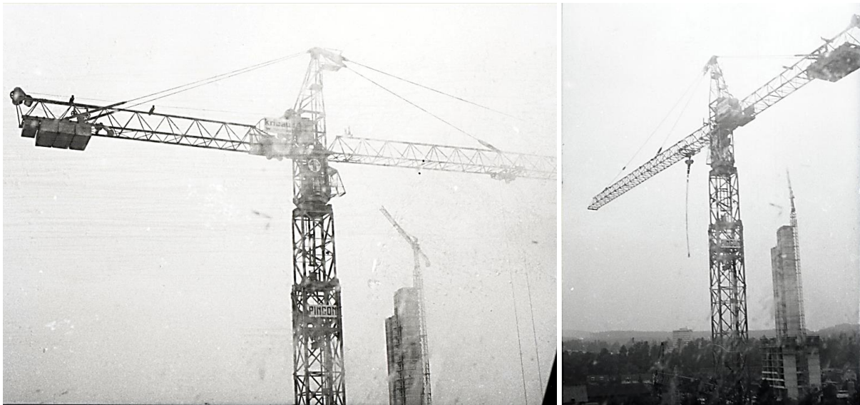
Pingon S.4071.08. Im Hintergrund ist der Bau des Telli Hochhauses im vollen Gang. Der Richier-Weitz Kran GT 1184, ist mit dem Gebäudekern hochgekllettert. Foto Pius Meyer.
