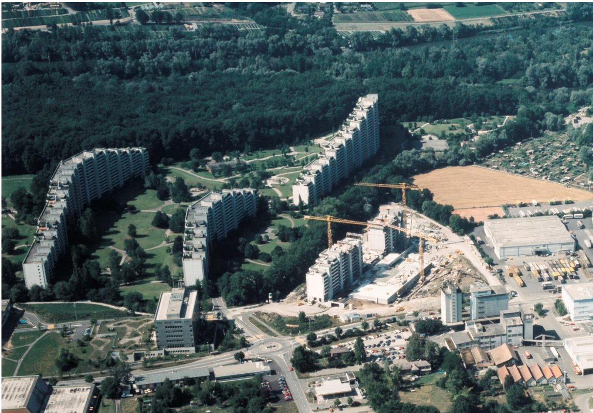
Telli Stand 1988. Die Zeile D wird als Letzte realisiert. Gut sind die 2 Stk. Richier-Weitz Krane vom Typ GT 1184 du GT 1194 und ein BPR GT 222B (rechts) zu erkennen. Durch die komplett unterirdische Erschliessung der Telli Wohnbauten, sind grosse Grünanlagen um die Zeilen herum möglich geworden. Es entsteht der Eindruck von Wohnen im Grünen. Foto © ETH Bibliothek Zürich, Bildarchiv.
