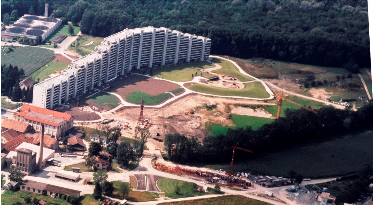
Telli Stand 1974. Die Zeile A ist fertiggestellt, die Zeile B wartet auf den Baubeginn. Die Krane sind bereits teilweise montiert. Foto © ETH Bibliothek Zürich, Bildarchiv.
