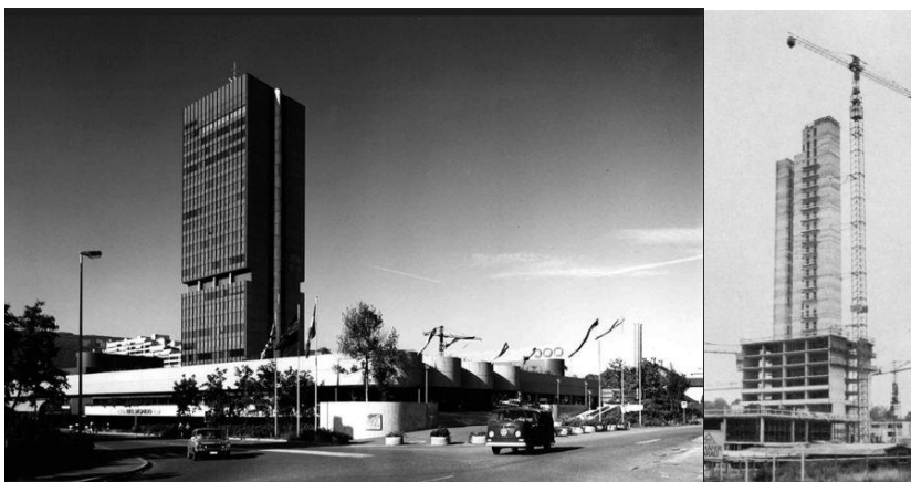
Das Telli Hochhaus in Bau 1972. Der rund 80 m hohe Gebäudekern mit den Liftschächten wurde vorgängig in nur 27 Tagen erstellt, damit mit einer Gleitschalung gearbeitet werden konnte. Fotos Archiv Pius Meyer und Hans Gisler.
