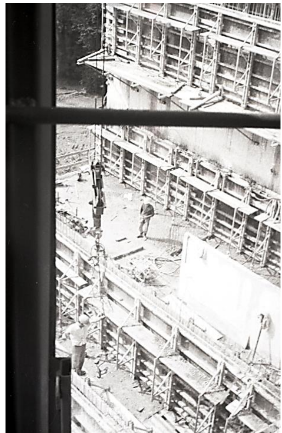
Blick aus der Krankabine. Gut zu erkennen, die Grossflächenschalungen des Systems «Allbeton» . Dieses System erlaubte eine schnelle und rationelle Erstellung der immer gleichen Grundrisse. Durch die offenen Fassaden, konnten die grossflächigen Deckenschaltische mühelos entfernt werden.
