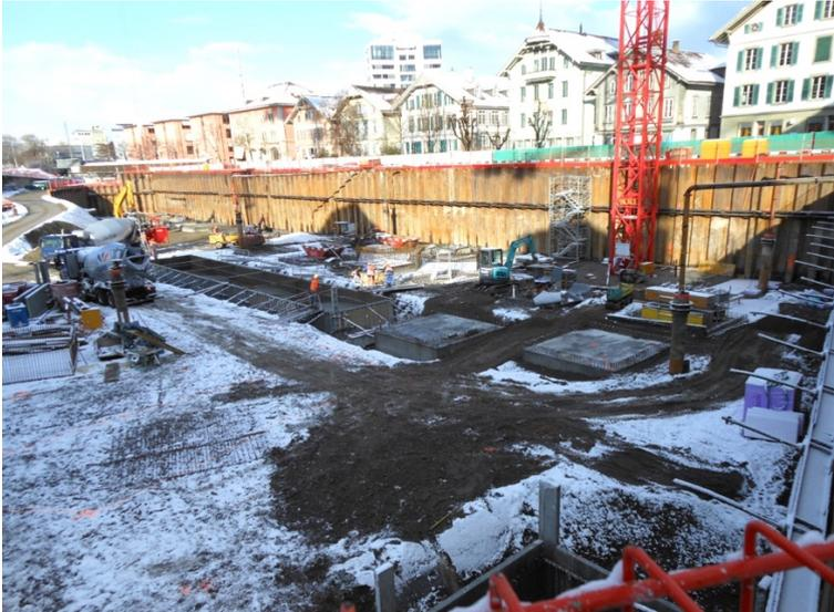
*Die Baugrube mit dem Turm Wolff 6531 cross auf einem Anker.
