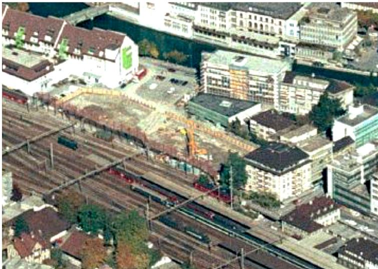
*Die Baugrube war ausgehoben und mit einer Spundwand gesichert. Im Vordergrund sieht man Gleise. Das «Aare Zentrum» links oben war gebaut.*
