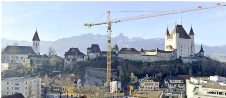
*Links vom Liebherr 280 EC-H wurde die Ein- und Ausfahrt gebaut. Es musste ein Turmdrehkran mit einer grossen Ausladung sein, um das Treppenhaus mit dem Lift auf den Schlossberg bauen zu können. Links ist die Schlosskirche, rechts ist das Schloss mit den Nebenbauten.
