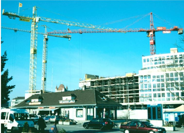
*Wolff 5520 FL eingesetzt beim Bau des unterirdischen Parkhauses, Potain Topkit H 30-30 C beim Bau des Hauptgebäudes. Beide Turmdrehkrane gehörten der Bauunternehmung Marazzi AG.*
