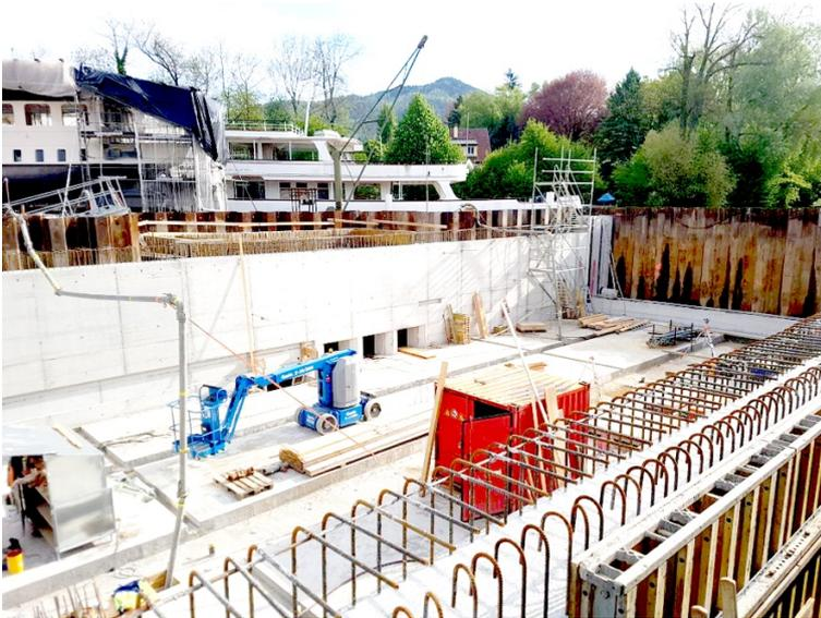
Die dicke Betonwanne war betoniert und ausgeschalt. Im Hintergrund sieht man ein Kursschiff. Um die Baustelle war eine Spundwand, welche das Eindringen von Seewasser verhinderte.
