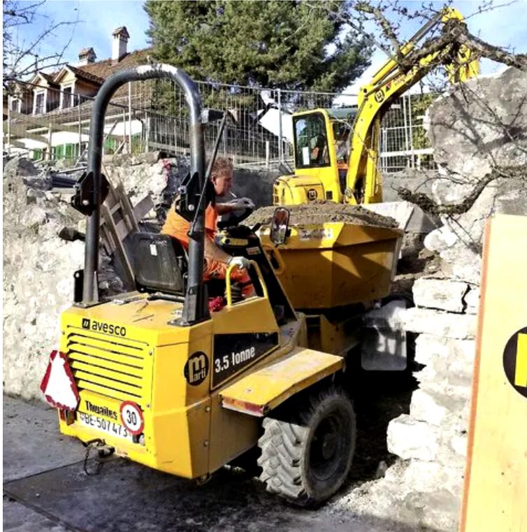
*Ein Einschnitt in eine alte Mauer auf dem Schlossberg musste zum Zugang zum unterirdischen Parkhaus ausgebrochen werden.*
