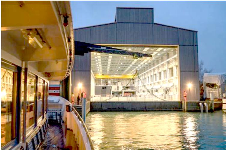
*Die Werfthalle wird durch ein wasserdichtes Tor abgetrennt. Dieses wird mit Hilfe von einem Säulendrehkran mit einer Funkfernsteuerung mit einer durchgehenden Tragkraft von 12.5 Tonnen vom Hersteller «Stahl» montiert. Erst danach kann das Wasser in der Halle abgepumpt werden.*
