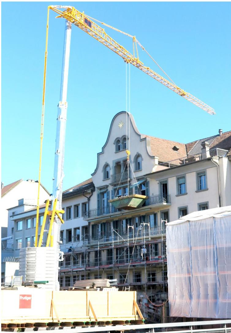
Mit Hilfe eines Potain Hup 40-30 wurde das Pflegeheim Falken renoviert. Der Schutt zur Entsorgung wurde aus den Zimmern in eine WELAKI (wechseln/laden/kippen) Mulde geworfen. Dies ist generell verboten, da die Mulde beim Beladen immer schwerer wird und unter Umständen zu schwer für den eingesetzten Turmdrehkran ist. Die temporäre Baubrücke wurde durch Frutiger AG erstellt und später demontiert.
