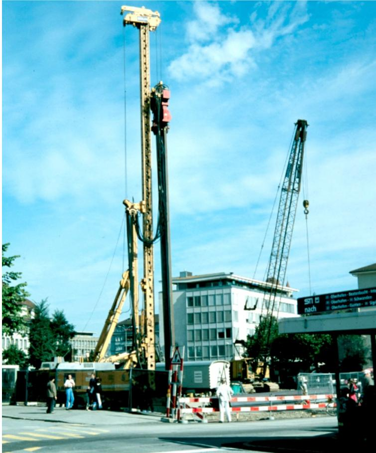
Weil das Gebäude in der Nähe des Schiffkanals ist, musste gepfählt werden. Im Hintergrund sieht man das Gebäude der Kantonbank.
