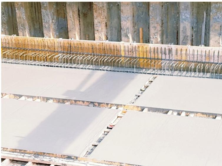
*Nach dem Giessen der armierten Bodenplatte mit Pumpbeton.*
