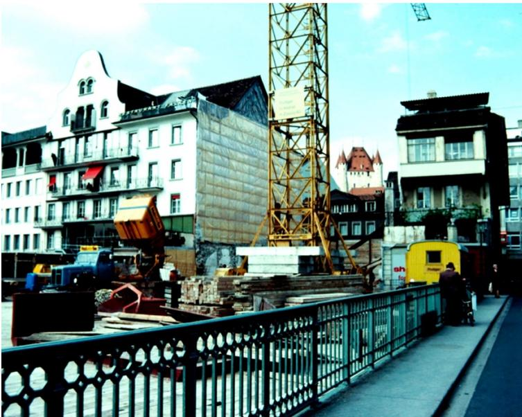
*Weitz X 1220 stand auf einer Baubrücke über der äusseren Aare. Rechts ist die Postbrücke. Das Hotel Falken auf der linken Seite wurde einige Jahre später mit Hilfe eines Potain Hub 40-30 auf einer provisorischen Baubrücke umgebaut. Hinten sieht man einen Teil des Schloss Thun.
