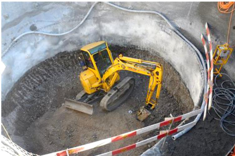
*Die Öffnung vom Schlossberg in die Kaverne für den Zugang durch eine Treppe und einen Lift war im Bau. Der Turmdrehkran brauchte eine grosse Ausladung, um auch diesen Teil der Baustelle im Schwenkbereich zu haben.*
