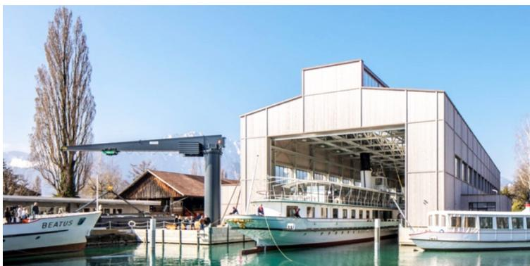
Erst nachdem das Schiff (im Beispiel das Dampfschiff «Blümlisalp») in der Halle genau am vorhergesehenen Standort vertäut ist, kann das Unterwassertor mit Hilfe des Säulendrehkrans geschlossen werden. Nun folgt das Abpumpen des Trockenbeckens.
