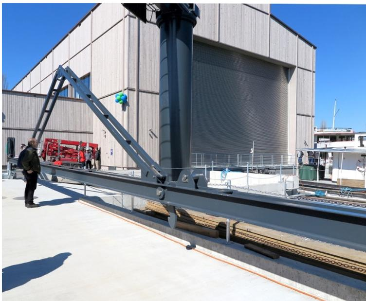
*Mit Hilfe dieser Spezialtraverse wird das Unterwassertor geschlossen und geöffnet. Über der Wasseroberfläche wurde ein 17 m breites Rolltor zum Schliessen der Werft besonders im Winter montiert.*
