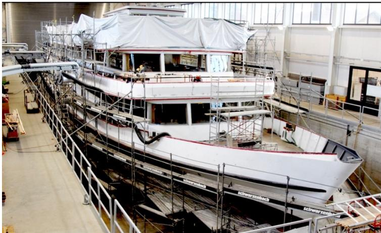
Die Renovation des Motorschiffes «Stadt Thun» von der Öswag Werft Linz AG mit Platz für 1'100 Menschen im Trockenbecken. Bei der Renovation wurden Baugerüste eingesetzt.
