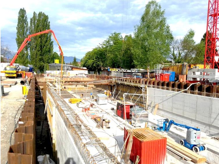
Die zum Teil betonierten Seitenwände der Betonwanne.
