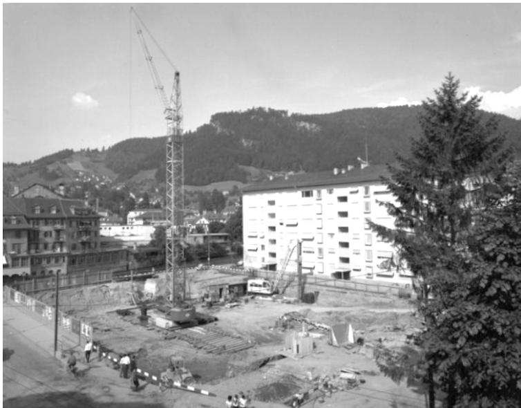
*Die aktuelle Filiale war im Bau. Die Baugrube war ausgehoben und der EWK SBK 36 h Gigant hoch war montiert und im Einsatz. Rechts von der Mitte wurden noch Pfähle gebohrt. Hinter der Baugrube ist die äussere Aare.
