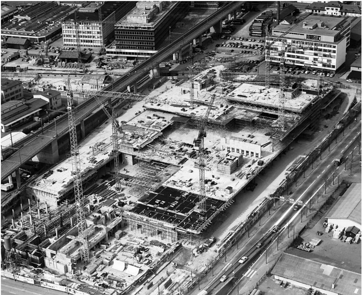
Bauzustand am 03.04.1973. Der mit 71.6 m Hakenhöhe Liebherr 90.2 HC links im Bild, wurde dann auch zur Erstellung des Hochkamins benötigt, welcher auf dem Bild noch nicht zu sehen ist. Foto ETH Bildarchiv
