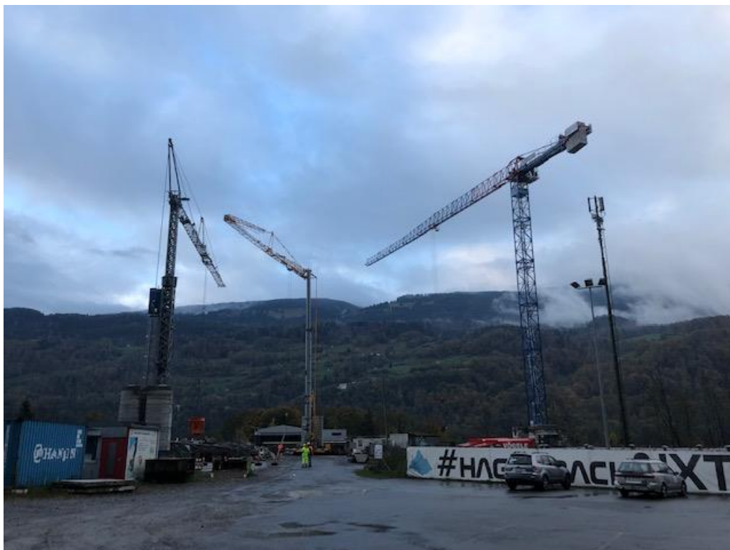
Kranpark Flums-Hagerbach 2022 mit 3 Krane
