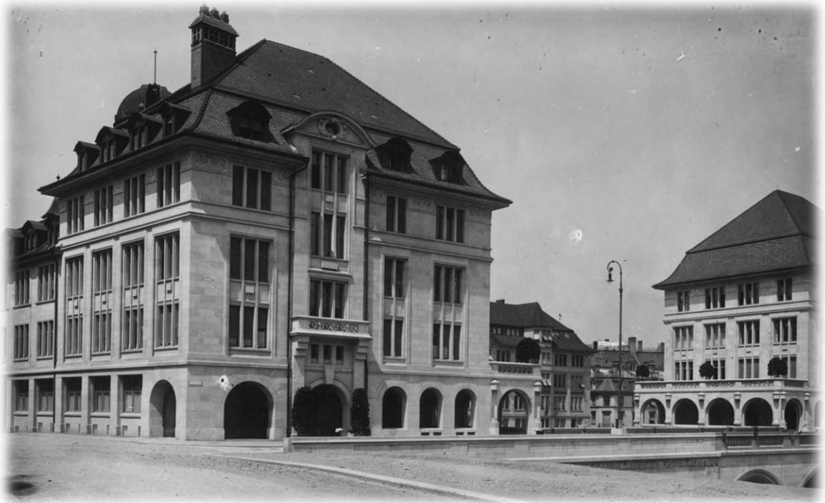
Amtshaus IV in Zürich
