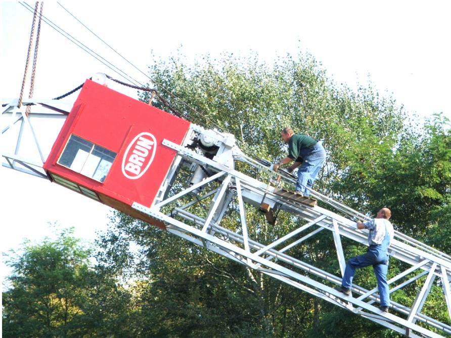
Der MTK 18 bei der Montage mit Hilfe von einem Pneukran.
