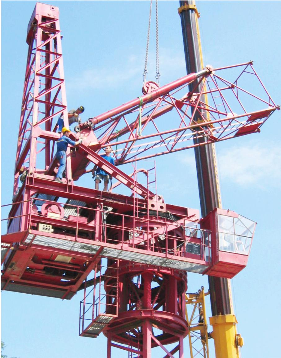
Die mächtigen Hydraulikzylinder wurden an der Drehbühne abgebolzt und an das Ausleger-Anlenkelement gebunden. Nun konnte das Ausleger-Anlenkelement auch demontiert werden.
