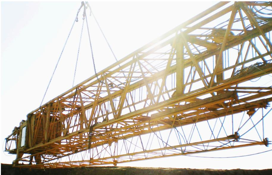
Der Turm mit umgeklappter Turmspitze und Teile des Auslegers hingen am Pneukran.
