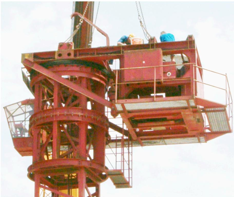
Die Drehbühne wurde am Pneukran angeschlagen und wurde danach demontiert.
