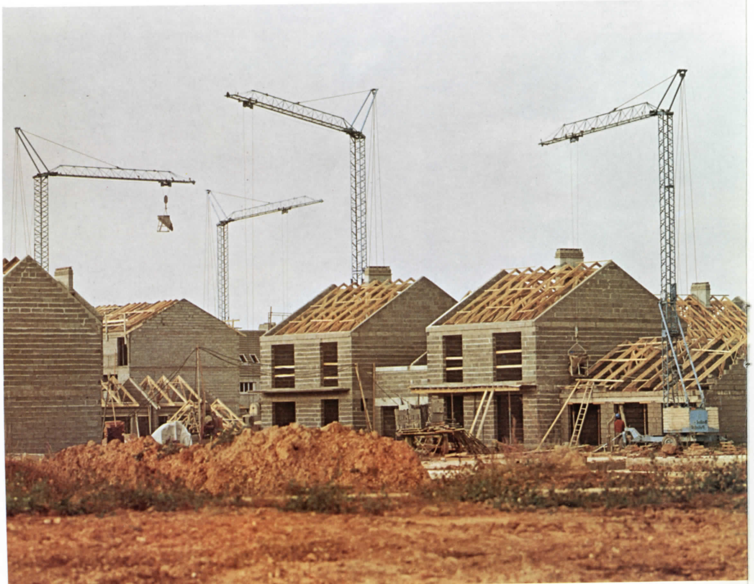
Beispiel des Einsatzes eines Boilot-Kranes bei der Errichtung von Pavillons.
