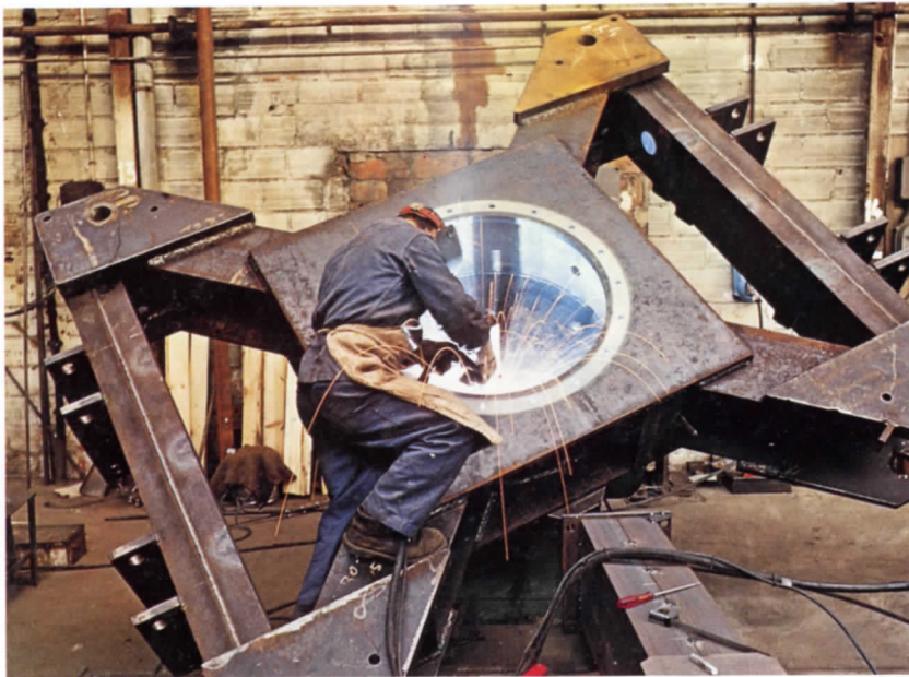
Fertigstellung des Unterwagens auf einer drehbaren Plattform.
