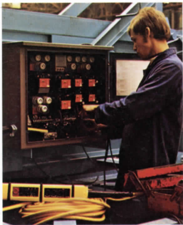
Einbau der Fernsteuerung.
