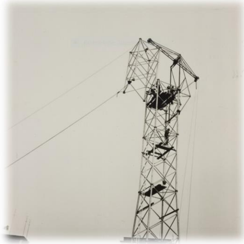
Hier das Hochziehen und Einsetzen eines kompletten Turmstücks elektrisch mit einer Winde und Muskelkraft vereint
