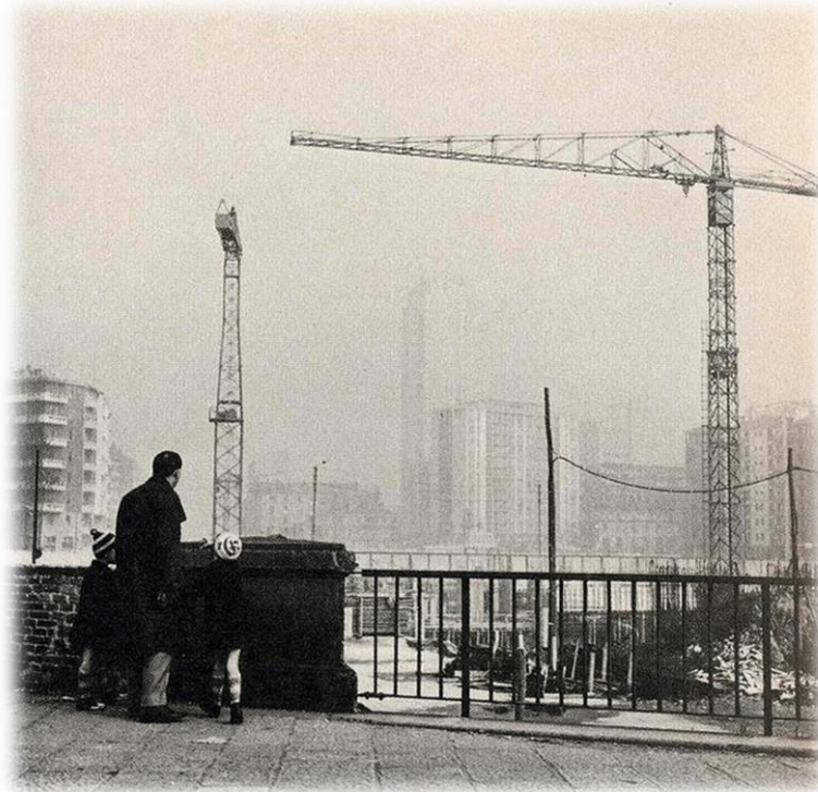
Rechts der neue Magutt Teleskop – Turmdrehkran auf einer Mailänder Grossbaustelle im Einsatz
