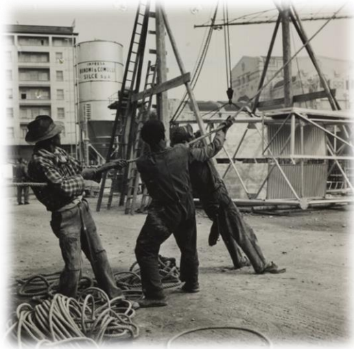
Hier das Hochziehen und Einsetzen eines kompletten Turmstücks elektrisch mit einer Winde und Muskelkraft vereint
