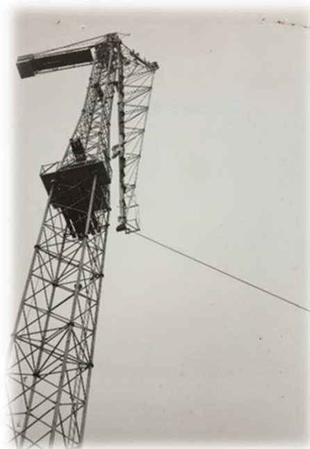
Das Hochziehen und Aufrichten des Gegenauslegers wie auch des Auslegers.
