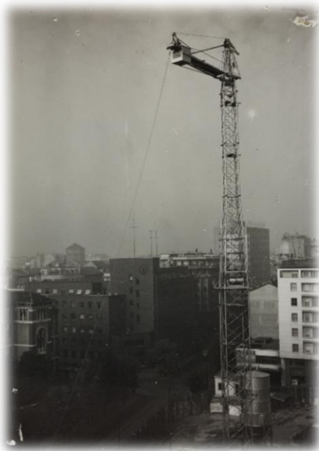
Das Hochziehen und Aufrichten des Gegenauslegers wie auch des Auslegers.
