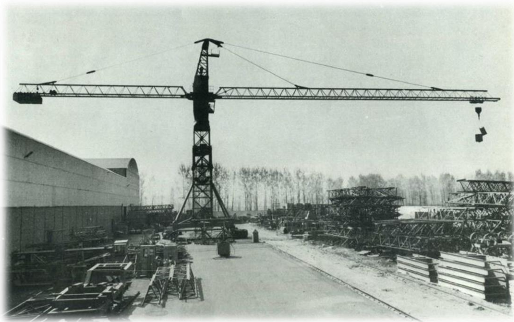
LP 350 Kran Probemontage im Werk Assago (MI)
