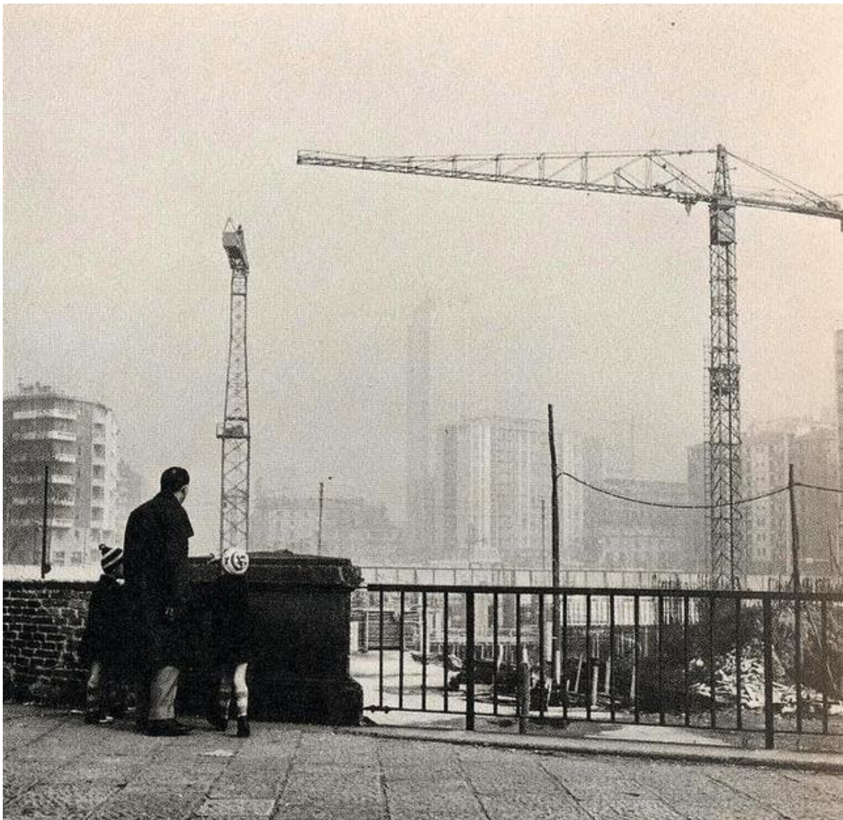
Links im Bild, der MAGUTT1 Kran, der herkömmlichen Konstruktion und rechts der neue Teleskop-Turmdrehkran MAGUTT2 auf einer Mailänder Baustelle.
