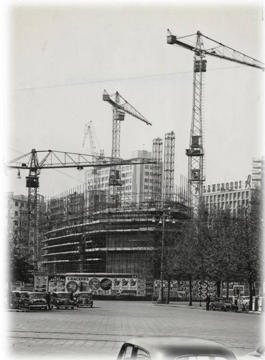
.....die drei Krane sind die Modelle 40 links mit leichtem, rechts mit stärkerem Ausleger. Im Hintergrund ist ein SEAM Doppelanker-Turmdrehkran ersichtlich
