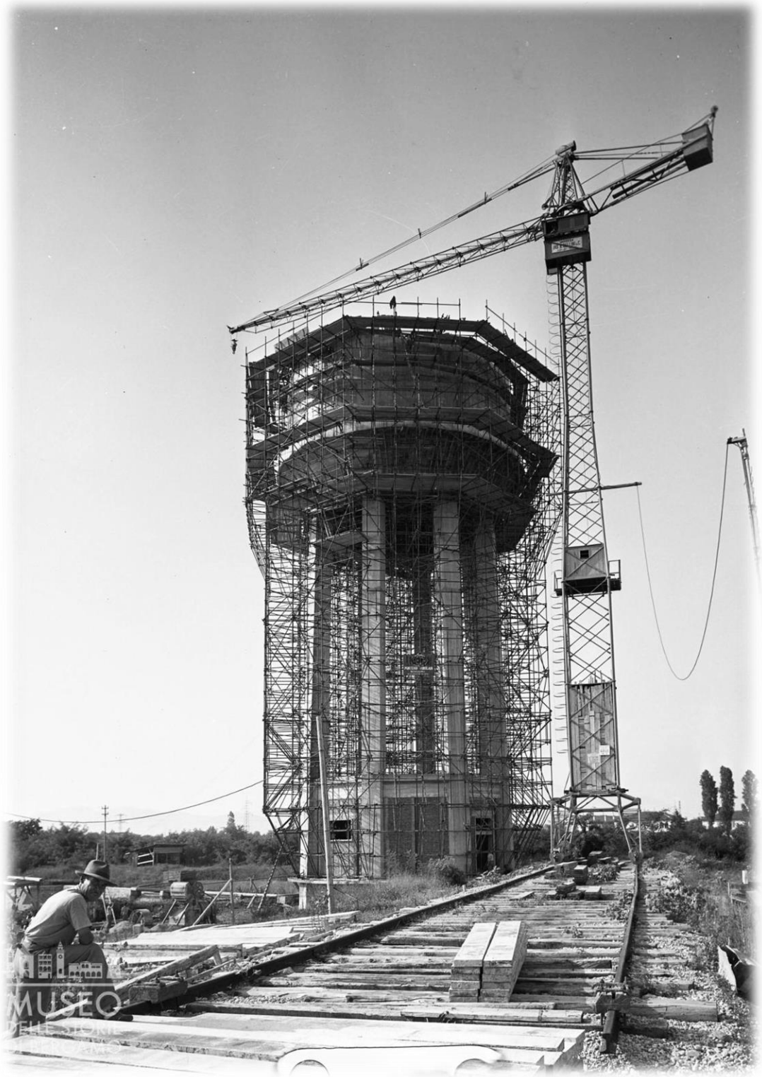
LORO & PARISINI Turmdrehkran Modell 40 mit Wippausleger
